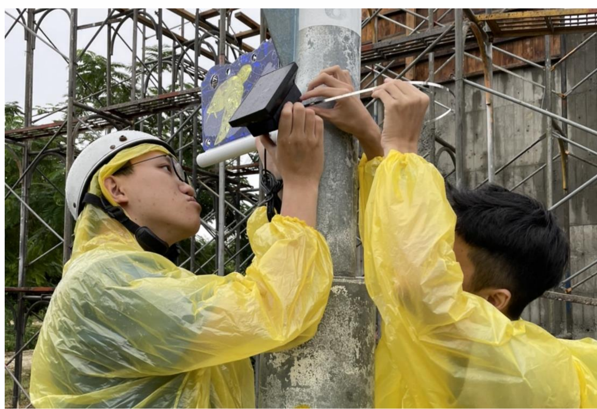
小琉球架設電助車設備
