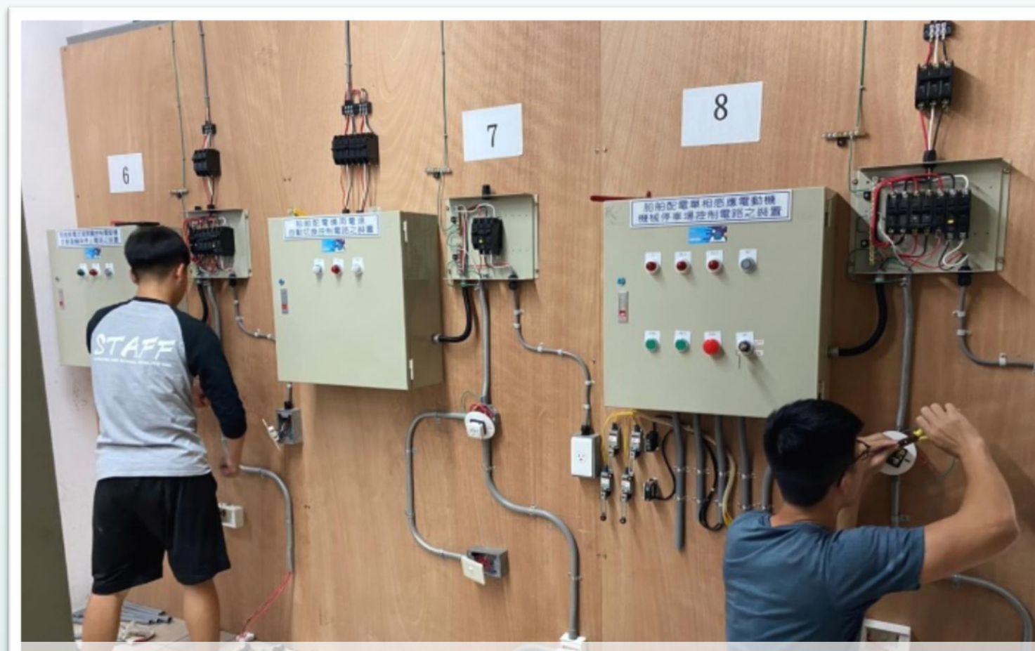
室內配線證照 - 分電盤配線實作
